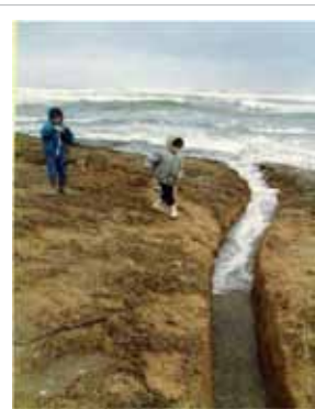
צילום 12- מפעל עתיק להפקת מלח דרומית לנווה ים-מ תעלות חצובות הובילו את מי הים לאגני ייבוש במרזבת החוף, תוך שימוש באנרגיית גלי הים
